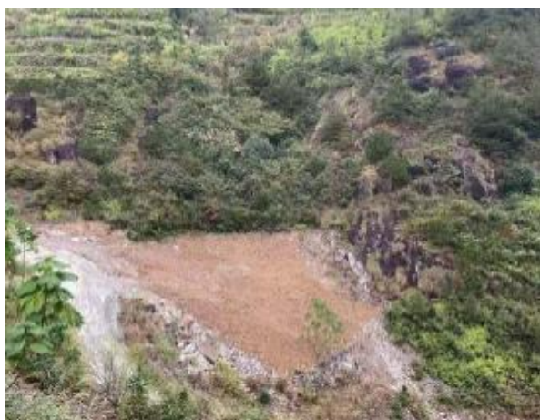
九龙隧道出口弃渣场
