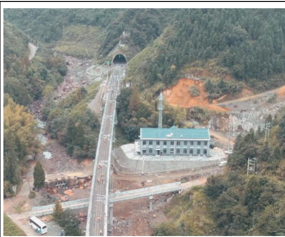
横溪站信号综合楼
