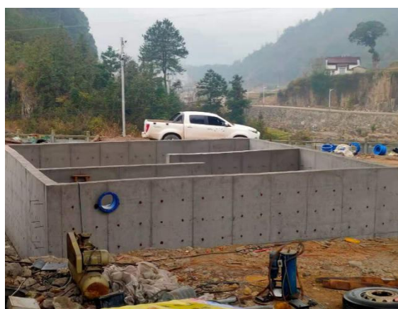
好溪3号桥事故应急池
