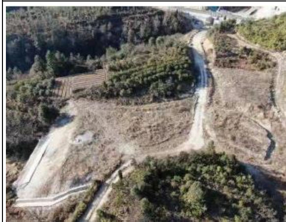
潘潭 1#隧道进口弃渣场
