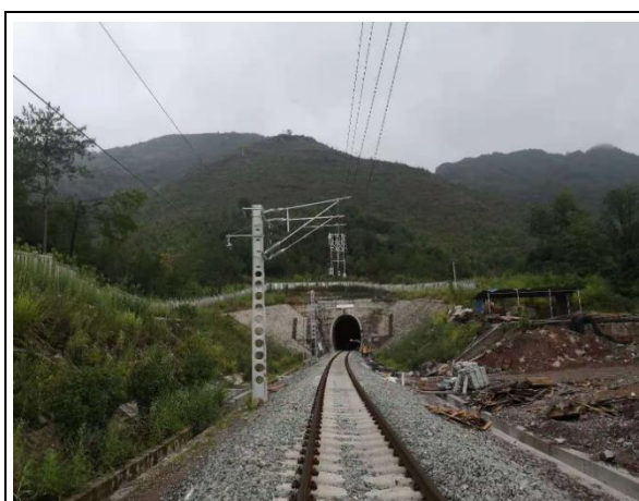
石锦隧道出口
