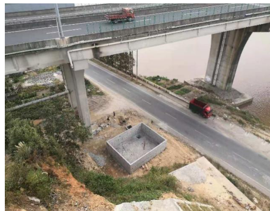
灵江特大桥桥侧事故应急池1
