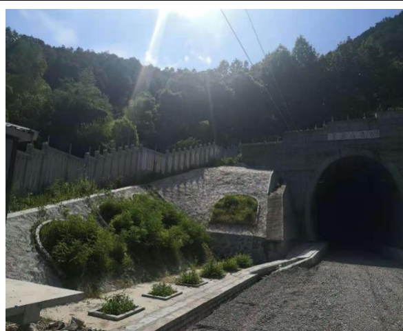
万岙山隧道出口
