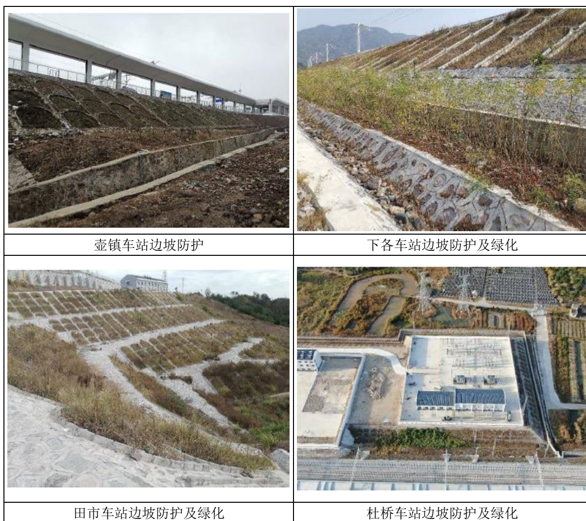
图 6.4-4 工程沿线场站防护情况
