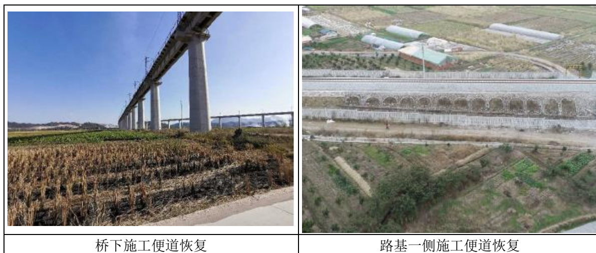
图 6.4-10 施工便道生态恢复情况
