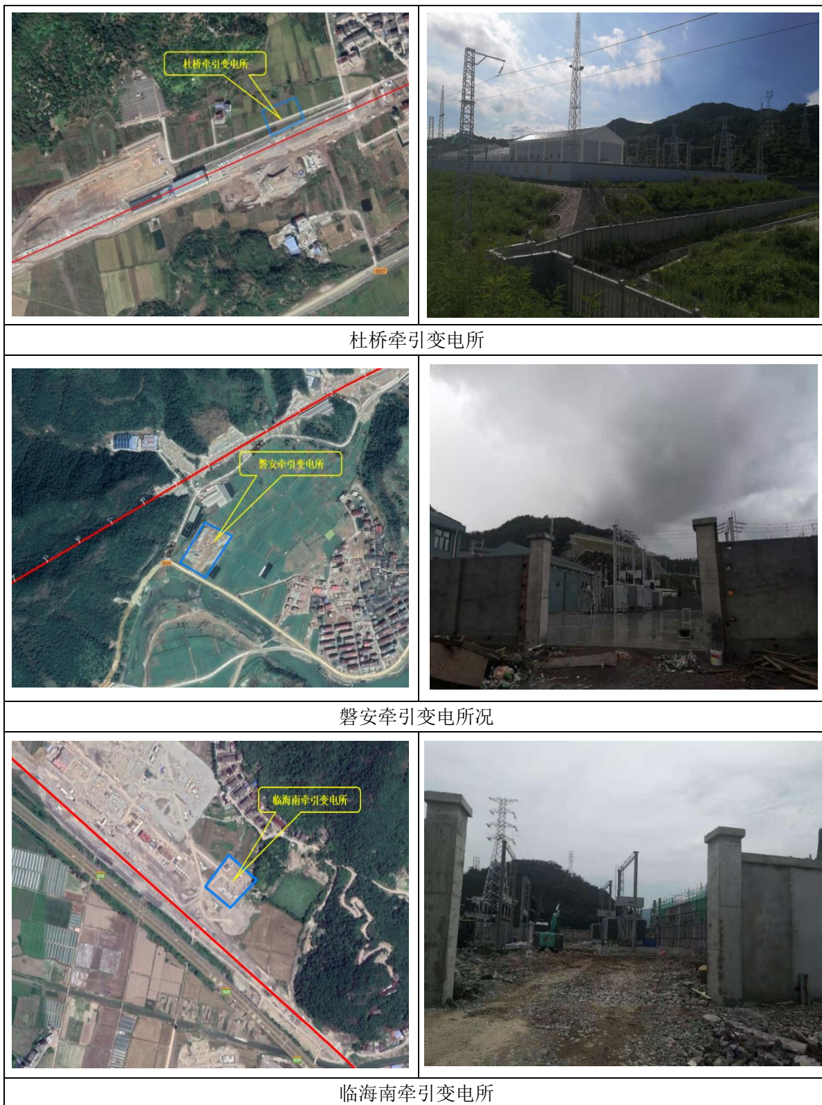
图 10.1-1 工程牵引变电所情况
