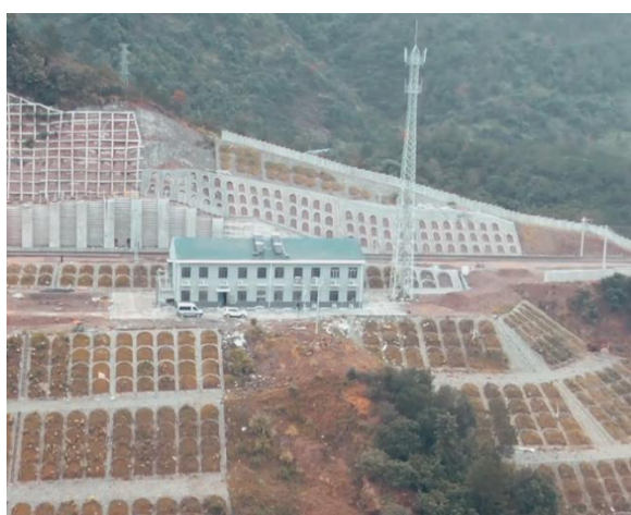
田市站信号综合楼
