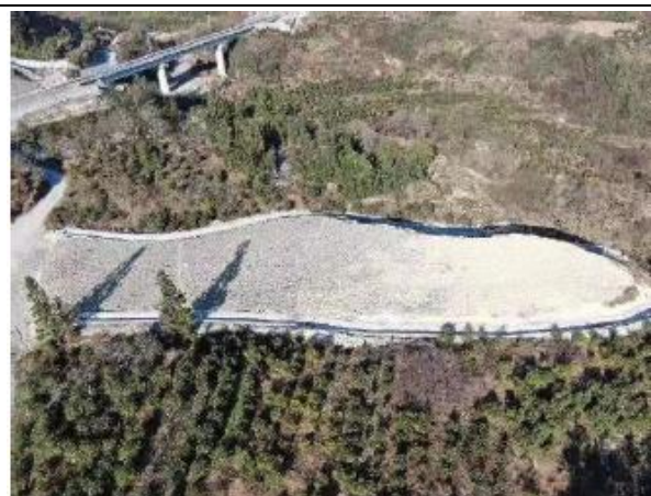
杨桥头隧道出口弃渣场
