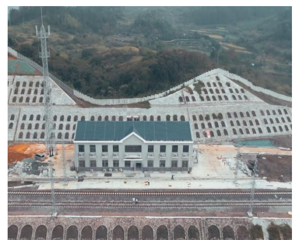
申亭站信号综合楼
