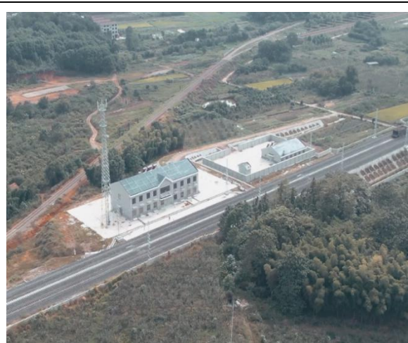
武义东站信号综合楼
