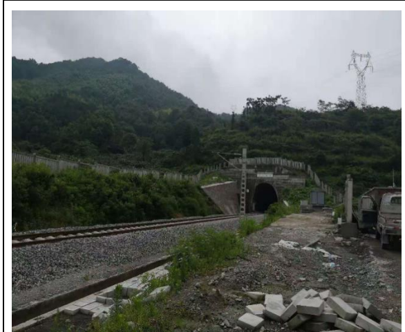
东山隧道进口
